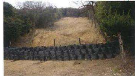
写真-1 平成 30 年災害・半田山被災状況
