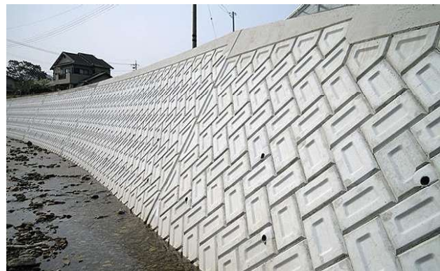
図-6 河川堤防の水抜き孔設置状況 6)
