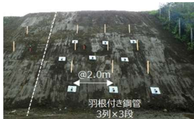
実盛土での試験施工状況
