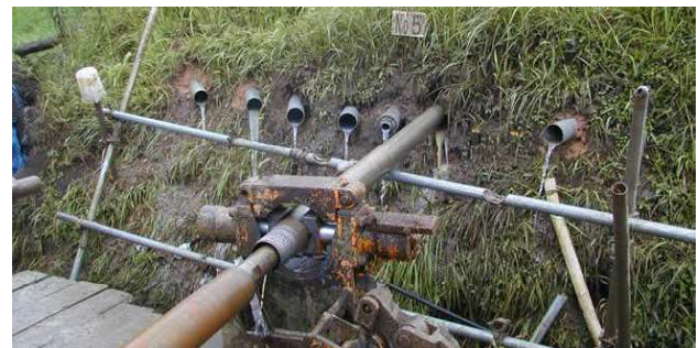
図-1 横ボーリング工の削孔と地下水排水の状況 1)
