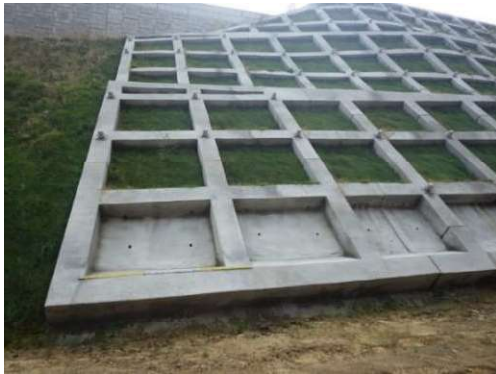
写真-7 吹付法枠とアンカー
