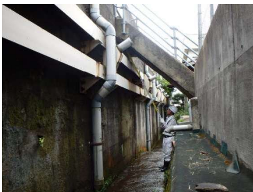
写真-9 土留め擁壁の補強アンカー
