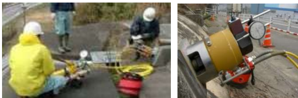
a. リフトオフ試験状況 b. ジャッキ部分 写真-3 SAAM(サーム) ジャッキシステム 8)
