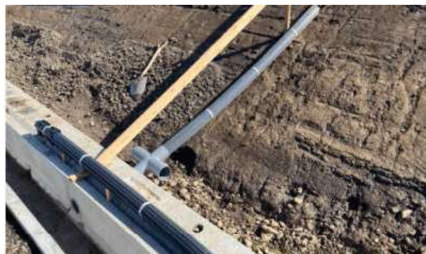
図-8 暗渠排水管の設置状況 8)
