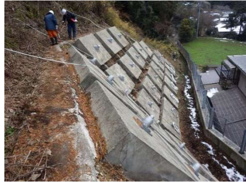
写真-10 RC 独立受圧板とアンカー
