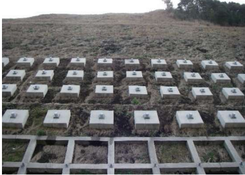
写真-6 RC 独立受圧板とアンカー (下段は吹付法枠と鉄筋挿入工)
