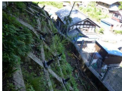
写真-11 吹付法枠とアンカー
