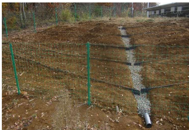
図-10 スロープ・ドレンの設置状況 10)
