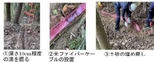
図-2 光ファイバーケーブルの設置状況
