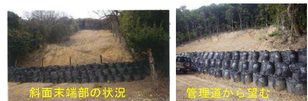
写真-2 西側崩壊斜面の状況
